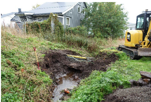
Figur 7 T.v.: Kulvert avdekket, med rørgate ovenfor. Foto mot nordøst. T.h.: Etter kulverten er fjernet. Foto mot nordvest. Merk rørene i forkant på høyresiden, og de to kummene.
