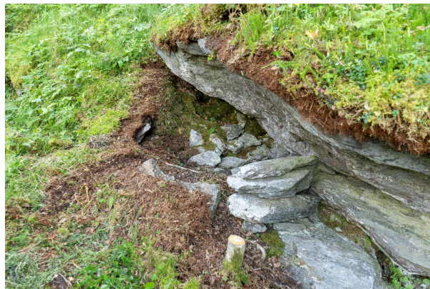
Figur 8 Øvre del av heller etter rensing. Oppmuring i forkant.
