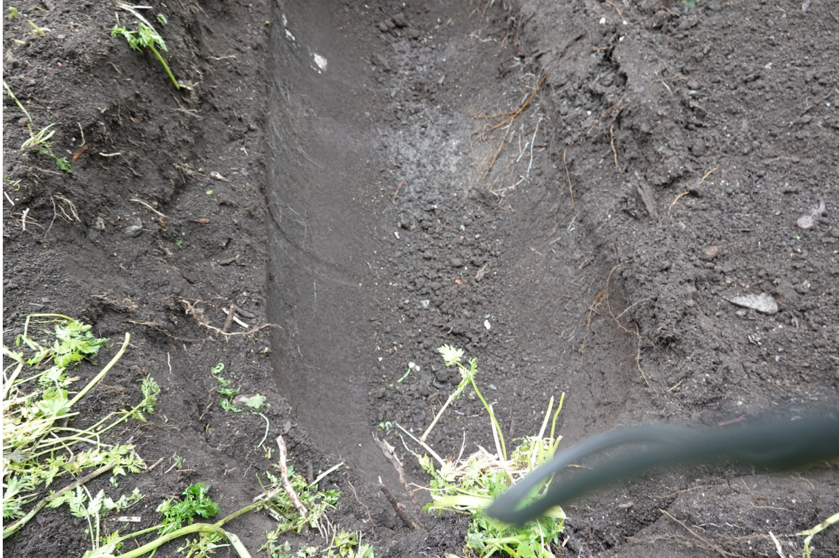
Figur 5 Oljetanken fjernet uten å berøre intakte gårdshaugsmasser.
