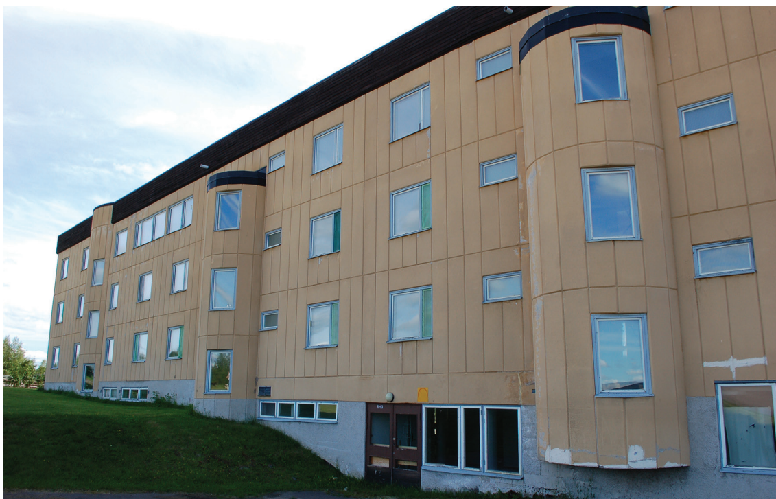
Ill. 14. Ormen langes vegg mot nord. Foto: Elin Haugdal 2010.
